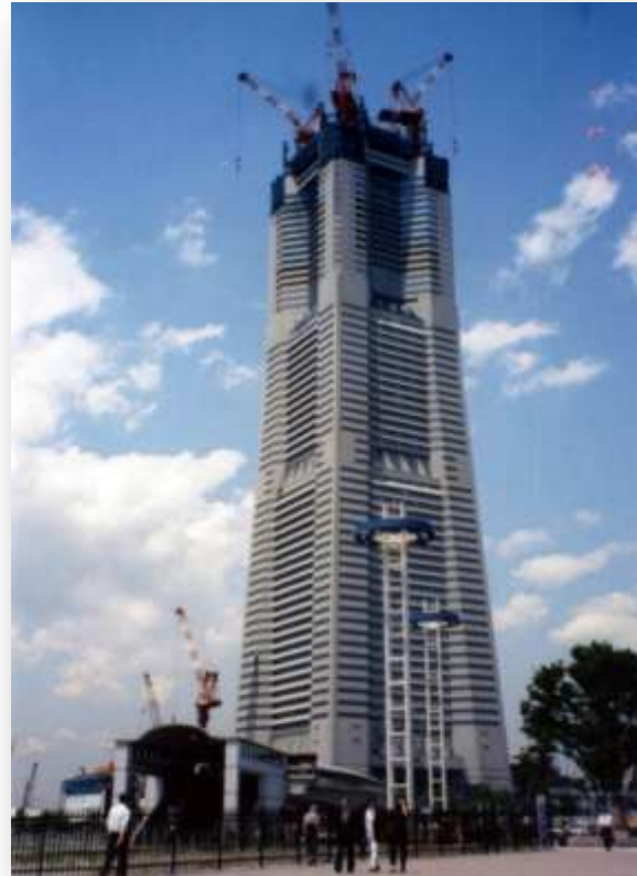
Budowa w 1992 r. najwyższego wieżowca Yokohama Landmark Tower. Construction of the highest building in Yokohama in 1992.
